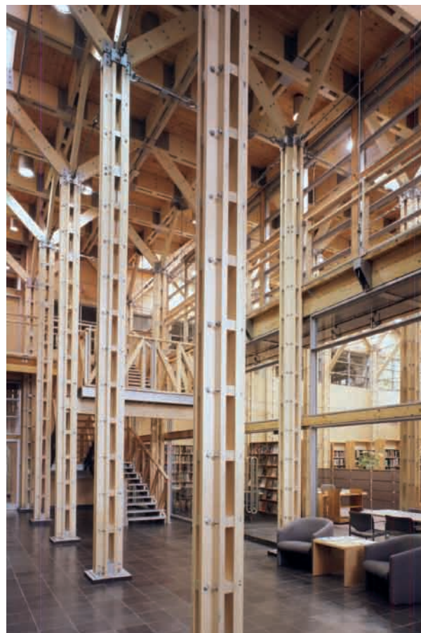
L'utilisation du bois dans les constructions publiques favorise le développement de nouveaux marchés.
